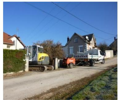
Novembre 2010, poursuite enfouissement des réseaux, côté gauche en montant, téléphone, eau potable, électricité, éclairage public, eaux usées ; côté droit, gaz et eaux pluviales. Janvier 2011 : remplacement des conduites anciennes d'eau potable du bas de l'impasse par l'Yssandonnais et la SAUR.
