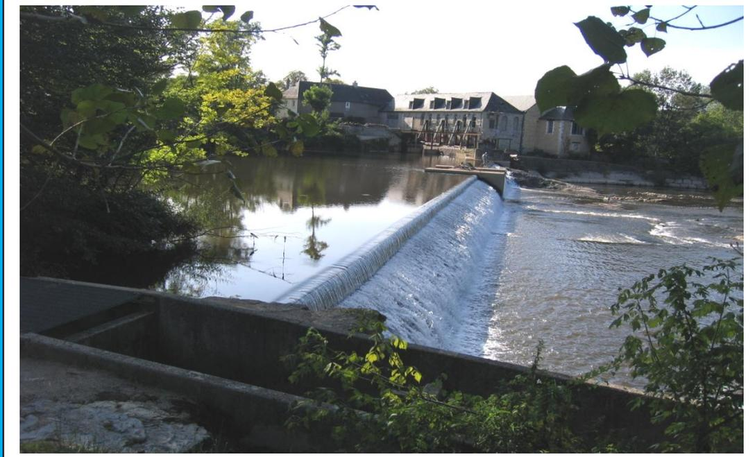
La digue des Escures sur la Vézère alimente en eau la centrale hydroélectrique située sur la rive terrassonnaise en Dordogne. Une passe à poissons a été construite sur la rive corrézienne. Cette usine électrique, est à l'origine du développement industriel de la commune de Mansac.
