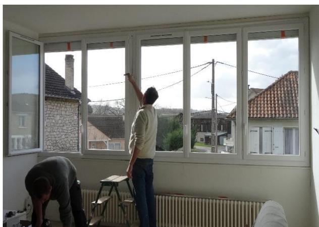
La municipalité a engagé des travaux de rénovation dans l'appartement situé au-dessus de La Poste. Des fenêtres isolantes ont été posées afin de limiter la déperdition de chaleur.
